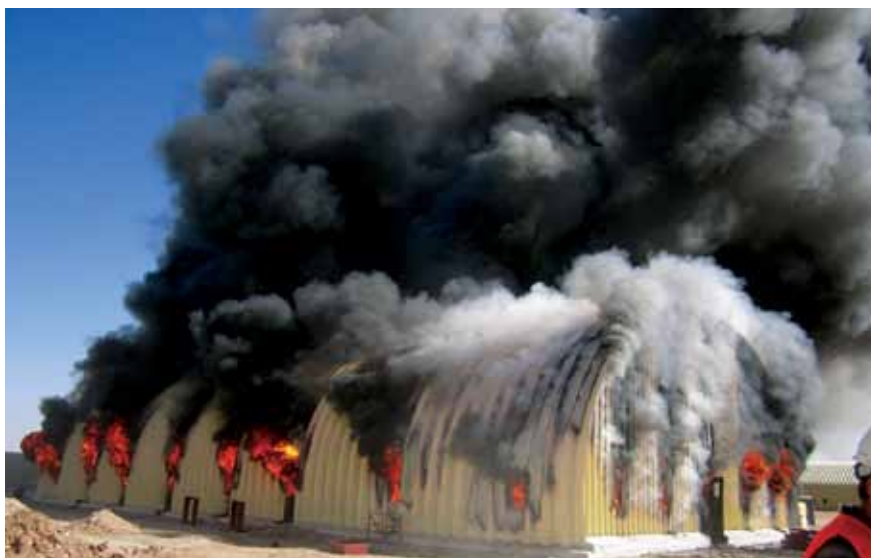
وقوع حریق در یکی از کلاسهای غیر استاندارد، این ساختمان را ظرف 30 دقیقه از بین برد. به پروژه خاص SP-14-77 مراجعه کنید. (عکس از USACE)
